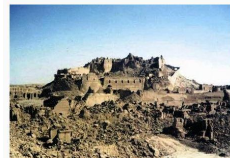
La citadelle de Bam après le tremblement de terre de 2003
